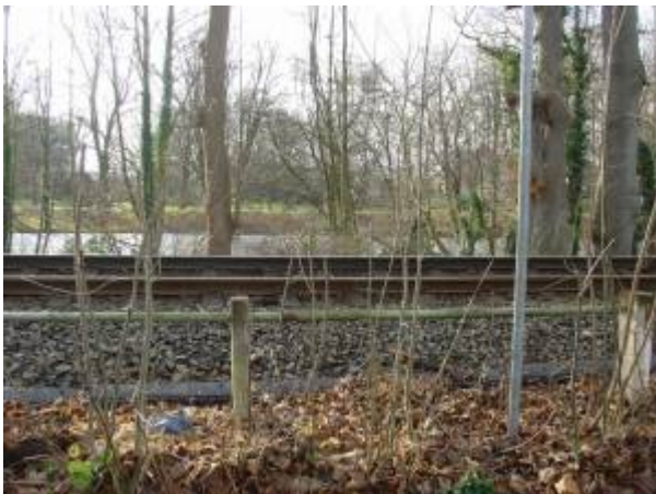
Ansicht „Brückenkopf“ zur anderen Seite der Rur. Selbstverständlich wird der Brückenkopf erst nach dem Gleisbett anfangen.
